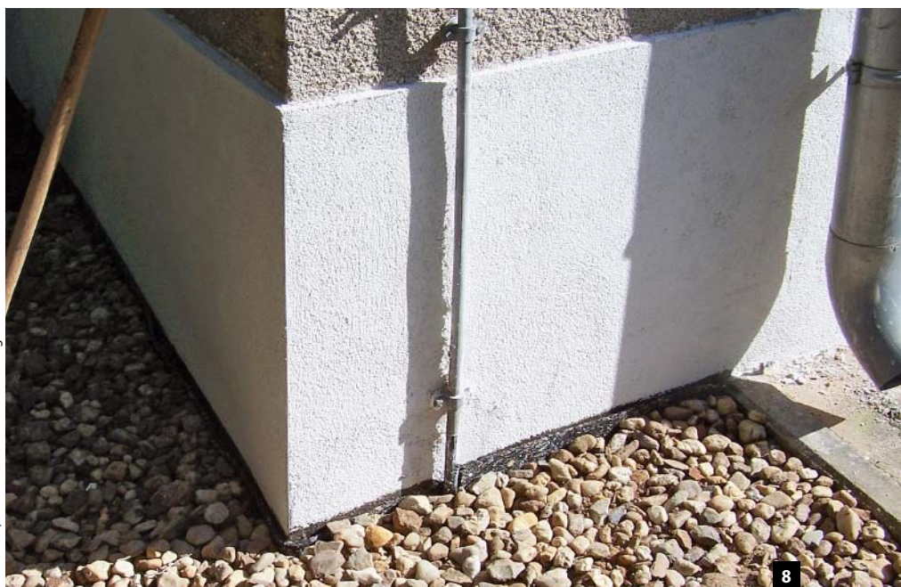
Abb. 8: Der Gebäudesockel wurde neu abgedichtet und verputzt.
